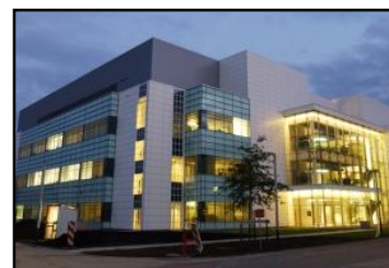
Figuur 4.1 Buitenzicht PJRC
